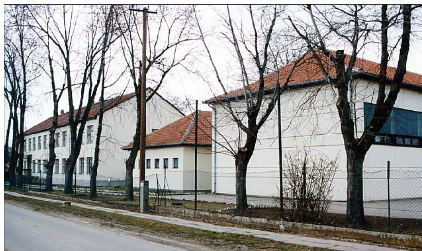
Az 1986-ban tornateremmel bővített Árpád úti épület 2000 őszén
